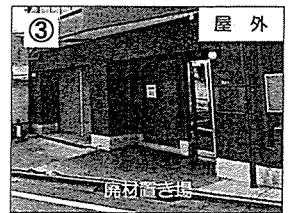
電気室前に撤去した廃材置場を設置いたします。
